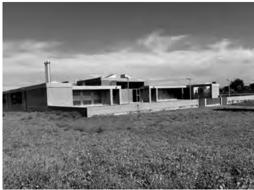
Seewasserwerk Frasnacht (Bild: Urs Bucher)
