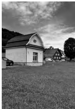
Pumpwerk Rietli Gais (Bild: René Hornung)
